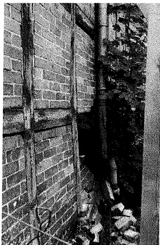
Bydgoska 52, ściana północno- zachodnia
